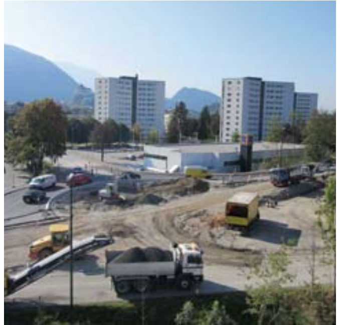
Bauarbeiten am 6. Oktober
